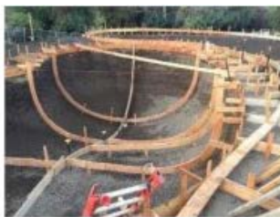
3 pav. Lenktos armatūros įrengimas.
