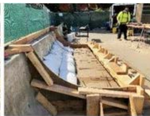
3 pav. Lenktos armatūros įrengimas.
