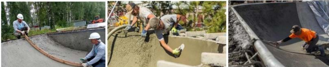
4 pav. Betoninio paviršiaus išlyginimas ir užtrynimasis rankiniu būdu.
